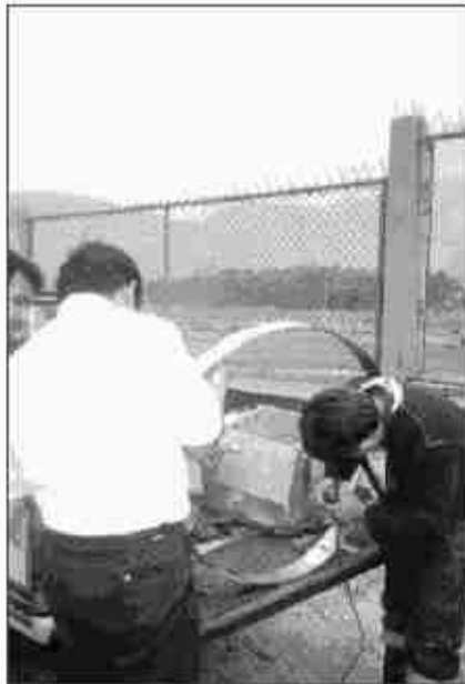
◦ Instalación del sensor de velocidad.
